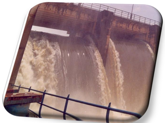
Centrale Hydroélectrique de Selingue
